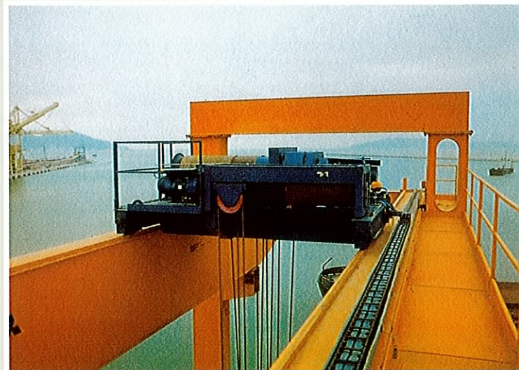
Gru a cavalletto - Portata t 40/20 - Scartamento m 35 Gantry crane - Capacity 40/20 t - Span 35 m
